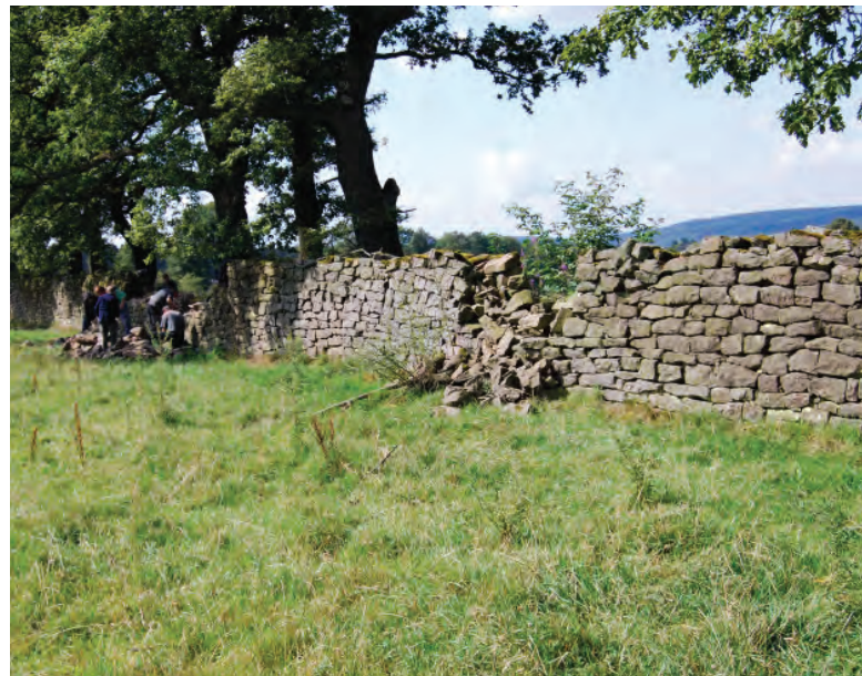
Historische Sandsteinmauern in Neuhaus im Solling während der Restaurierung (2009)
