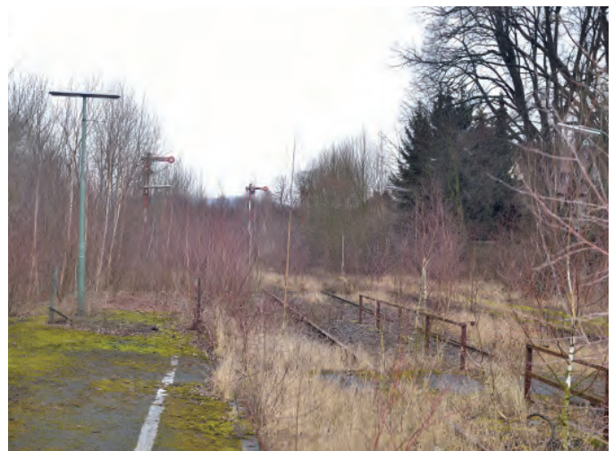
Abb. 20: Der aufgegebene Bahnhof von Bodenburg, Lkr. Hildesheim.
