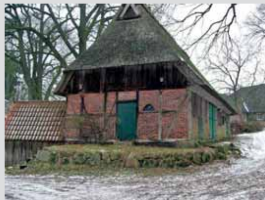
Schafstall O-Ansicht: Der ausgesprochen kleine Hofschafstall des Schroershofes beherbergte bis ca. 1910 die Heidschnuckenherde im Winter. Die Hofställe wurden deswegen auch Winterställe genannt. Nach Abschaffung der Heidschnuckenherde wurde der Stall zum Schweinestall, später zum Pferdestall umfunktioniert. (Foto: G. Grünhagen)
