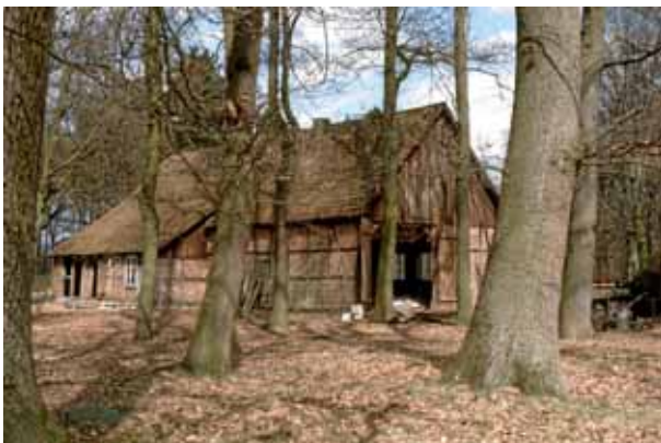
Das Arbeiterhaus von Südosten (Foto: T. Stracke, 1982)
