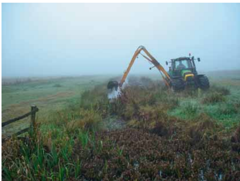
Grabenräumung (Foto: R. Kesel)
