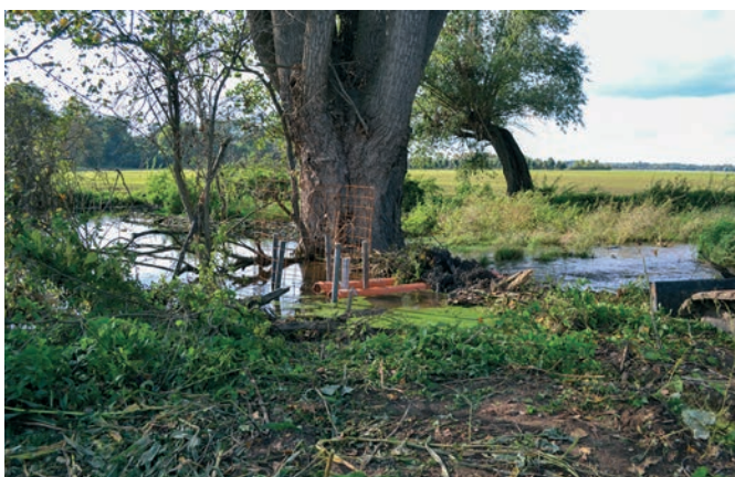
Abb. 4: Frisch gelegte Dammdrainage.
