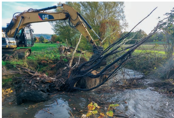
Nachher: Entfernen des Biberdammes mit anschließender Sortierung des Baumaterials und getrennte Entsorgung, nachdem festgestellt wurde, dass der Standort vom Biber aufgegeben wurde. (Fotos: Leineverband)
