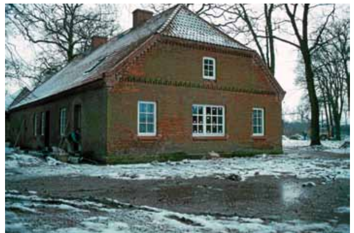
Das ehemalige Altenteil in der Umbauphase 1981. Hier entstanden Wohnungen für die letzte Eigentümerin Frau König, die Hausmeisterfamilie und für Gastwissenschaftler (Foto: T. Stracke)
