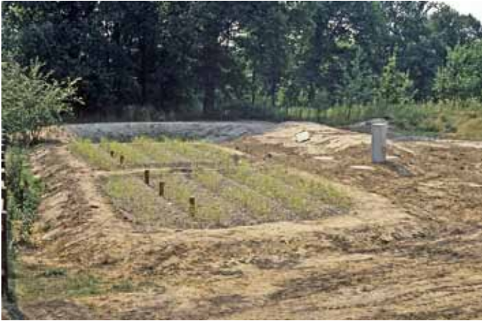
Die 1991 betriebsbereite Pflanzenkläranlage auf Hof Möhr (Foto: NNA-Archiv)
