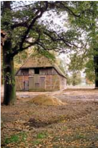
Der ehemalige Schafstall wurde 1981 umgebaut zum Versorgungsgebäude mit Heizungsanlage und Werkstatt (Foto: T. Stracke)
