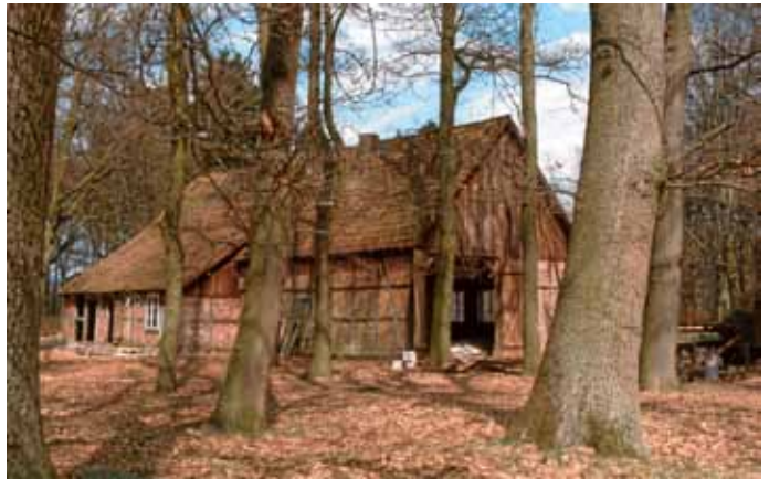
Ehemaliges Schäferhaus auf Hof Möhr in der Umbauphase im Frühjahr 1982. Es wurde zu einem Wohngebäude mit Räumen für Zivildienstleistende, Mitarbeiterinnen im Freiwilligen ökologischen Jahr, Praktikanten und Gastwissenschaftler(innen) ausgebaut. (Foto: T. Stracke)
