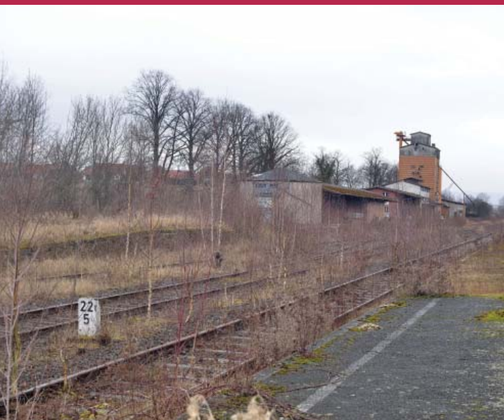
Abb. 2: Gleisanlagen und Lagerhäuser am Bahnhof von Bodenburg (Landkreis Hildesheim): Gestaltete Strukturen werden von dynamischer Natur überzogen.
