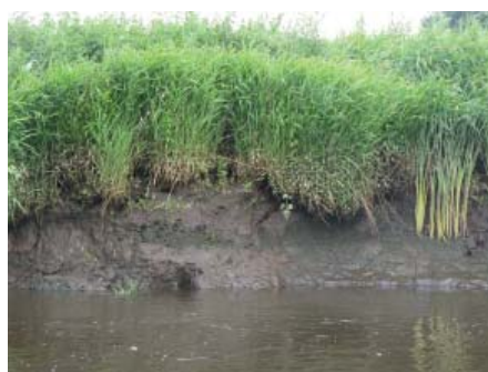
Weserausbau schädigt naturnahe Wümme: Uferabbruch an der Blocklander Wümme Foto: Gunnar Oertel
